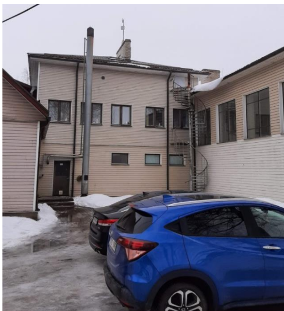
Foto: Mansardkorruselt varuevakuatsiooniteena kasutatav metallist keerdtrepp.
