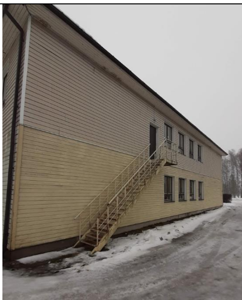
Foto: Lasteaia osast varuevakuatsiooniteena kasutatav metalltrepp.
