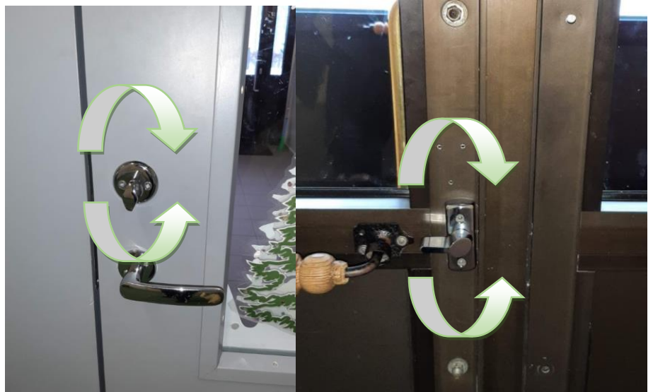
Foto: Evakuatsiooniks mõeldud ukсед on varustatud evakuatsioonisulustega.
